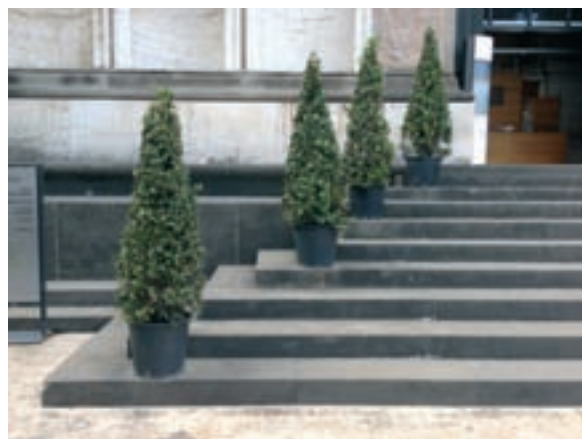
Fig. 4 – Per ovviare alle carenze di progettazione si è ricorso a interventi «tampone», collocando una fila di alberelli nei punti più critici. Tale intervento, anche se argina parzialmente il problema, non è certo una soluzione risolutiva e in grado di compensare l'assenza del marcagrado e del corrimano.
