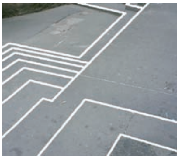
Fig. 2 - La mancanza di marcagradino, unito alla forma delle scale, che scendono su tre lati in modo irregolare, rende il tutto ancor più pericoloso. Servirebbe un marcagradino, come nel secondo fotomontaggio, per evidenziare la posizione e forma dei dislivelli.
