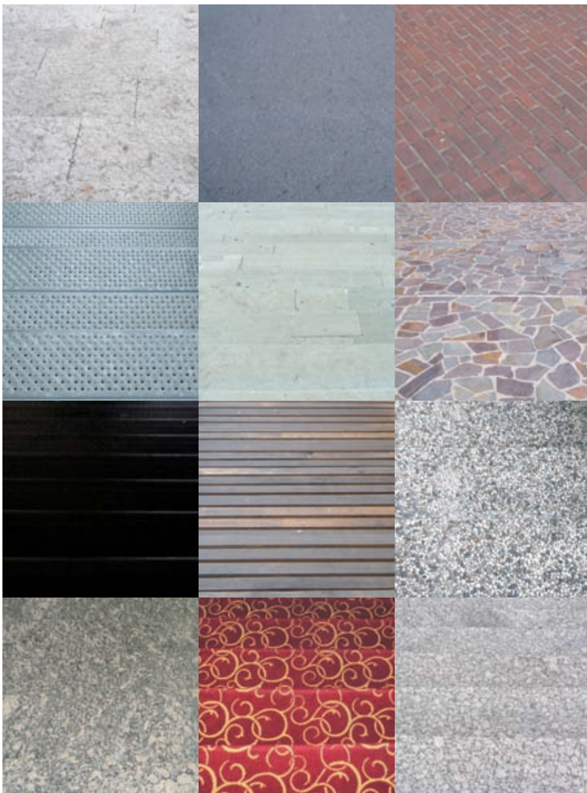
Fig. 3.2 - Se queste non sono barriere! Alcuni dettagli di scalinate viste dall'alto, diverse tra loro per tipologia e materiali costruttivi, ma accomunate dall'impossibilità di decifrare l'andamento dei gradini e quindi di capire dove siano i dislivelli. Queste sono immagini molto nitide. Immaginatevi cosa può vedere una persona ipovedente, o anche solo con una normale miopia o una leggera cataratta.
