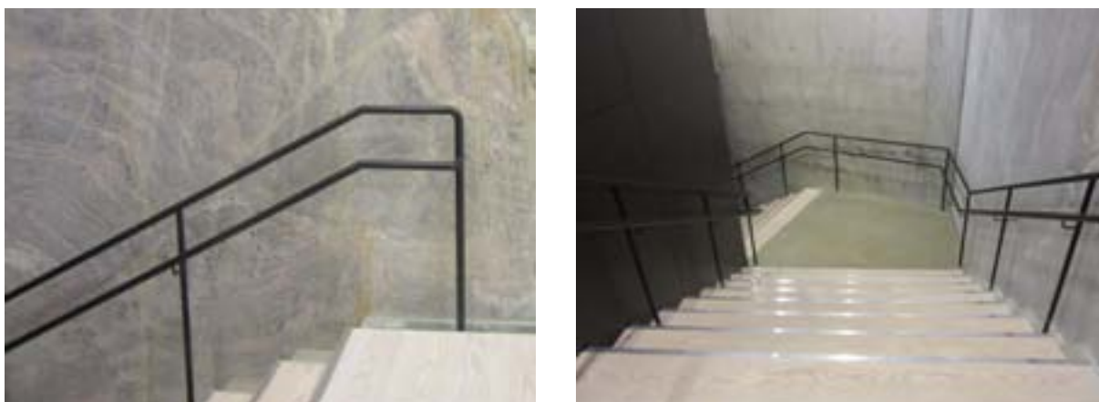
Fig. 3.4 – Esempio di corrimano correttamente prolungato di 30 cm oltre l'inizio e la fine della scalinata, che in corrispondenza del pianerottolo prosegue in orizzontale fino all'inizio della successiva rampa di scale e doppio, per poter essere utilizzato anche da bambini.
