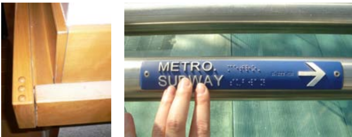
Fig. 3.5 – Sul corrimano possono essere fornite ulteriori informazioni attraverso segnali tattili (parole o numeri in Braille, «tacchette» o scanalature). Nella foto a sinistra il corrimano riporta un semplicissimo rilievo (non in Braille) per indicare il numero del piano raggiunto. La foto a destra raffigura una targa tattile in Braille e a grandi caratteri posta sul corrimano di una scala di una metropolitana.
