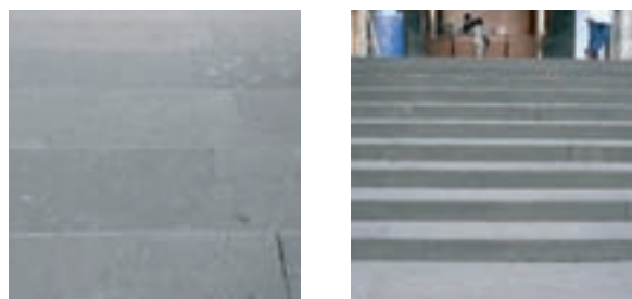
Fig. 1 - La stessa scalinata in discesa e in salita. In discesa l'assenza di un marcagradino ben contrastato crea un effetto «piano continuo». In salita invece l'occhio riceve molte più informazioni visive dalla luce che si riflette in modo diverso sulle superfici verticali e orizzontali.
