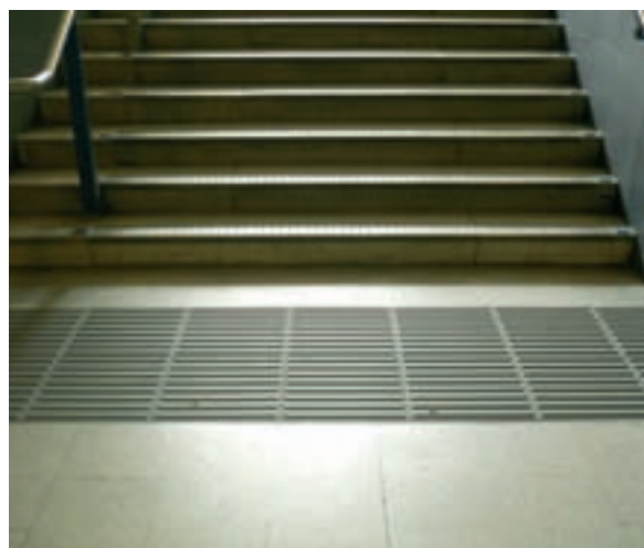
Fig. 3.3 – Due esempi di segnale al pavimento tattile. Il segnale deve essere presente sia all'inizio che alla fine di una scalinata.
